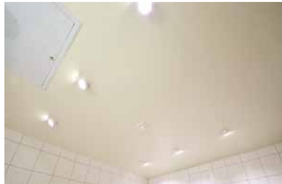
Taket i fiberarmert betong har ingen kassettskjøter.
